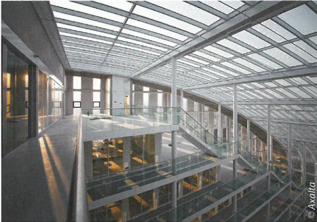
Die pulverbeschichtete Außenfassade des neuen Sitzes von Bruxelles Environment/Leefmilieu Brussel
